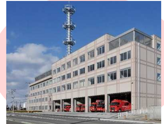
消防本部・八戸消防署
