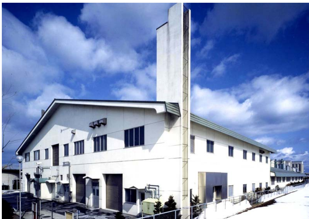
(災害復旧工事後)
