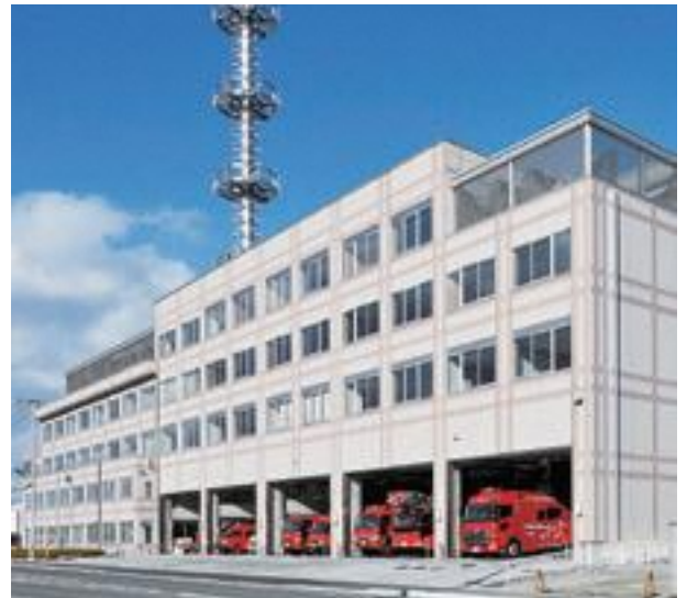
消防本部・八戸消防署
