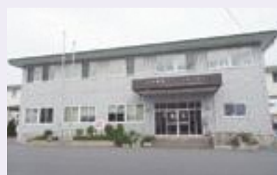
八戸環境クリーンセンター 管理棟
