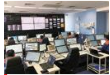
高機能消防指令センターの様子
