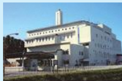
八戸清掃工場 第一工場
