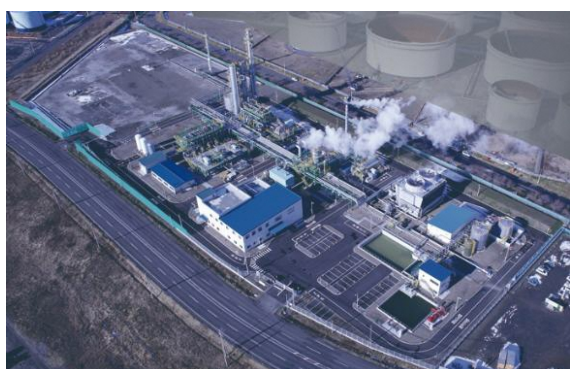
苫小牧CCS実証試験センター (画像提供：日本CCS調査株式会社)
