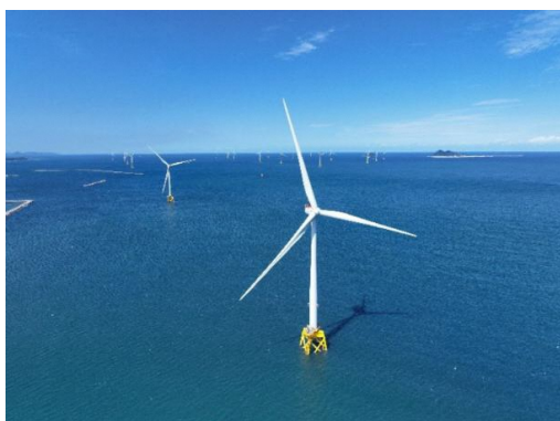
北九州響灘洋上ウインドファーム （画像提供：ひびきウインドエナジー株式会社）
