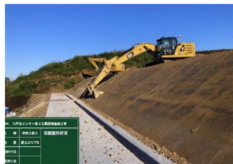
写真－2 法面整形状況
