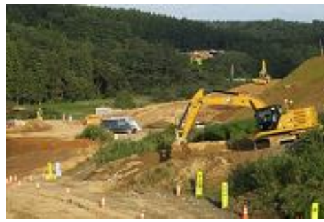
写真－4 盛土作業状況（安全看板）
