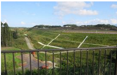
写真－3 法面完成状況（縦排水溝）
