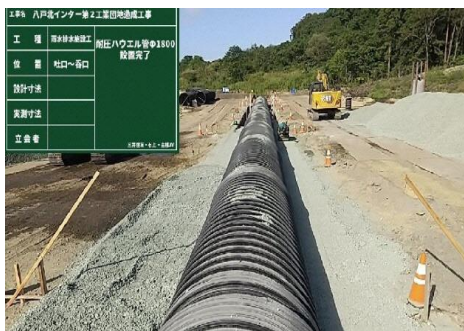
写真－1 耐圧ハウエル管φ1800 設置状況
