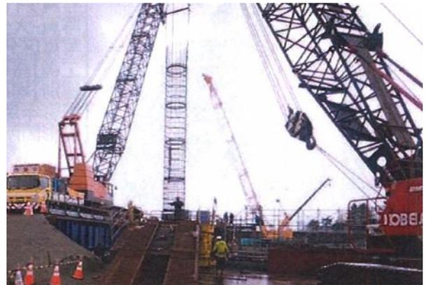
写真による確認ではあるが、場所打ち杭の施工においては、掘削長の検測、鉄筋籠の建て込み時のラップ長、コンクリート打設の天端高等の確認、立ち合いは実施されている。
