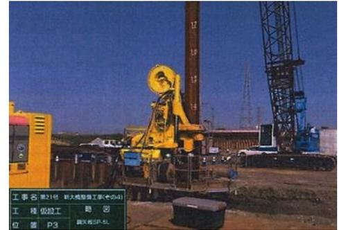
全周回転掘削機による場所打ち杭の施工は計画とおり施工されたとしている。
