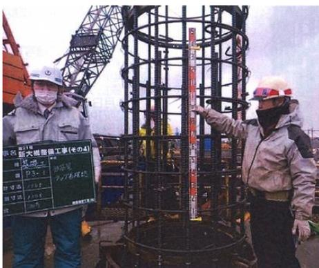
[写真 3] 鉄筋籠建て込み時のラップ長
