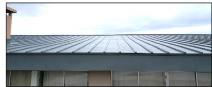
第 1 棟 3 階の屋根の状況 最大 60mm のたわみ
