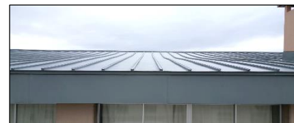
第 2 棟 3 階の屋根の状況 最大 90mm のたわみ
