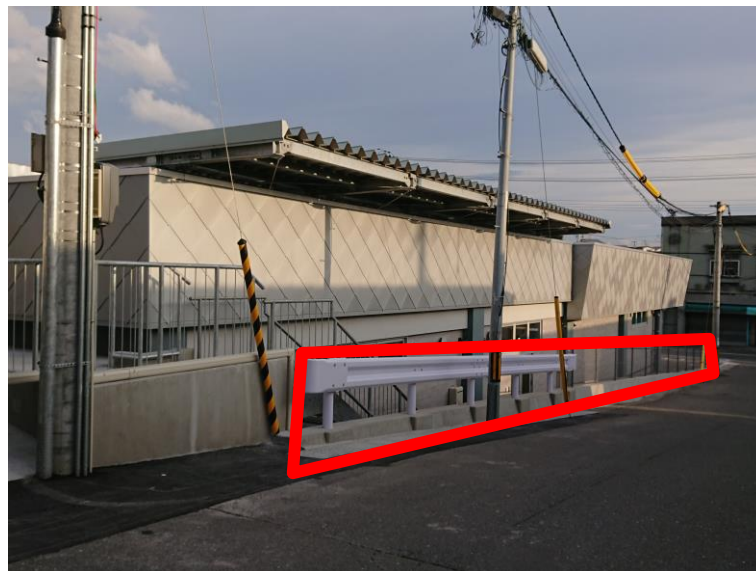
施工後の様子（赤線：増工箇所）
