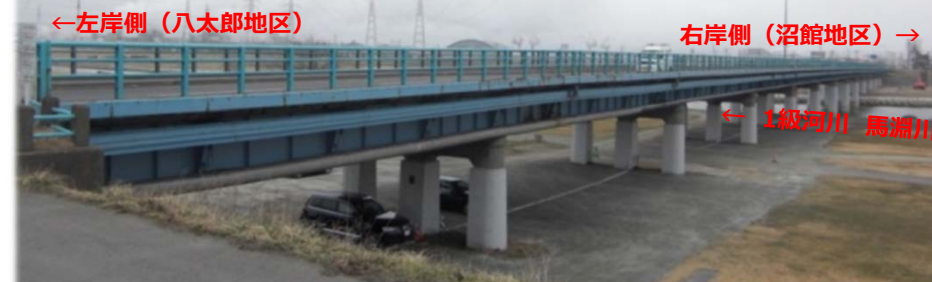
架替前の新大橋
