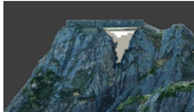
<補強材埋め立て後>
