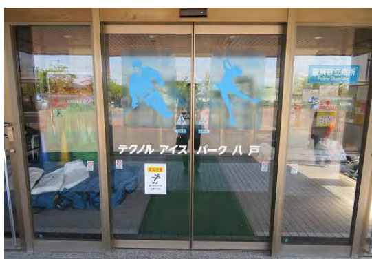
正面玄関自動ドア
