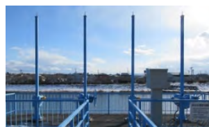
③放流ゲート開閉装置 （手動式から電動式へ更新）
