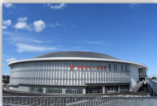
長根屋内スケート場
