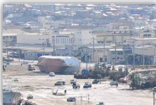
館鼻岸壁の東日本大震災の被害状況
