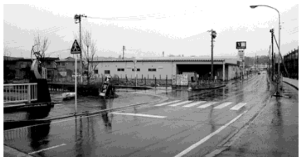
汚水中継ポンプ場が整備される予定の招運橋付近
