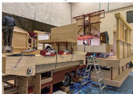
てつ 鉄でつくったほねぐみに、 いた 板などをつけて くみたて 組み立てる
