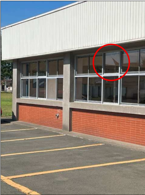
研修室東側 窓ガラス
