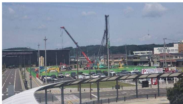
エルロン・ウエスト・ヴィレッジの工事の様子
