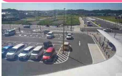
短時間無料駐車場を供用開始しました (H29年12月から)
