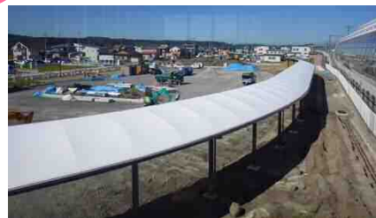
駅前広場工事が進んでいます
