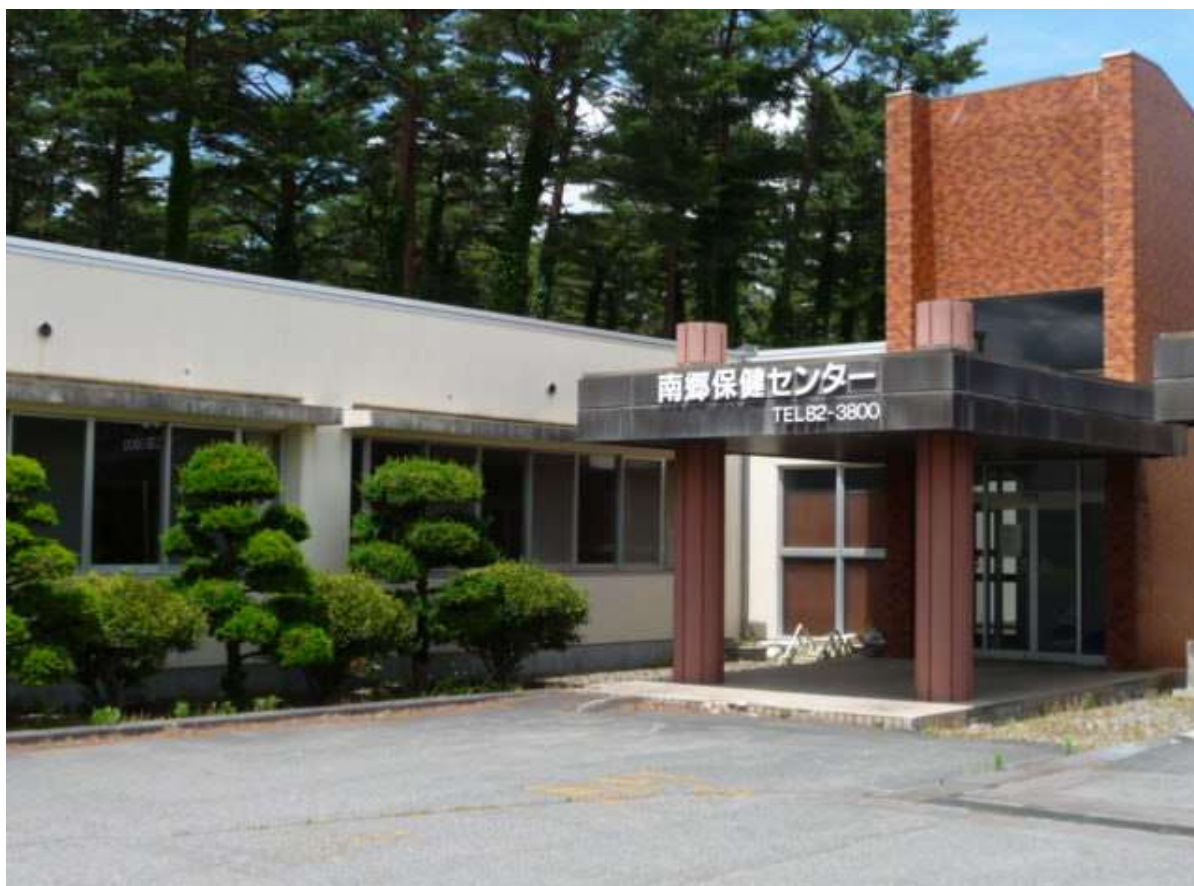
保健センター（外観）
