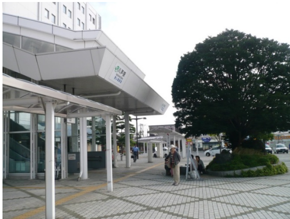
▲駅出入口から延びるシェルター（八戸駅東口）
