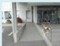
出入口の段差解消 事業費：30万円程度
