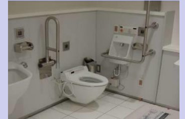
障害者対応型トイレ
