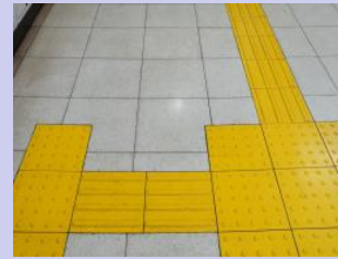
視覚障害者誘導用ブロック
