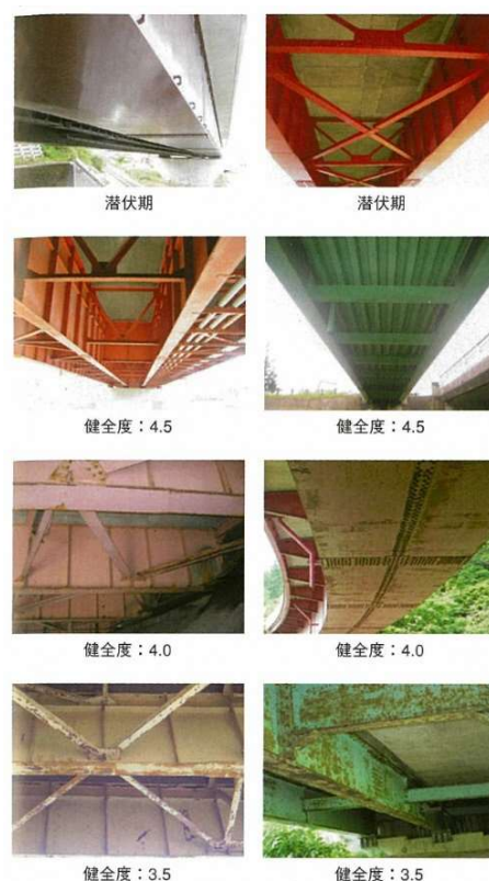
図8 健全度評価基準の例(点検ハンドブック)
