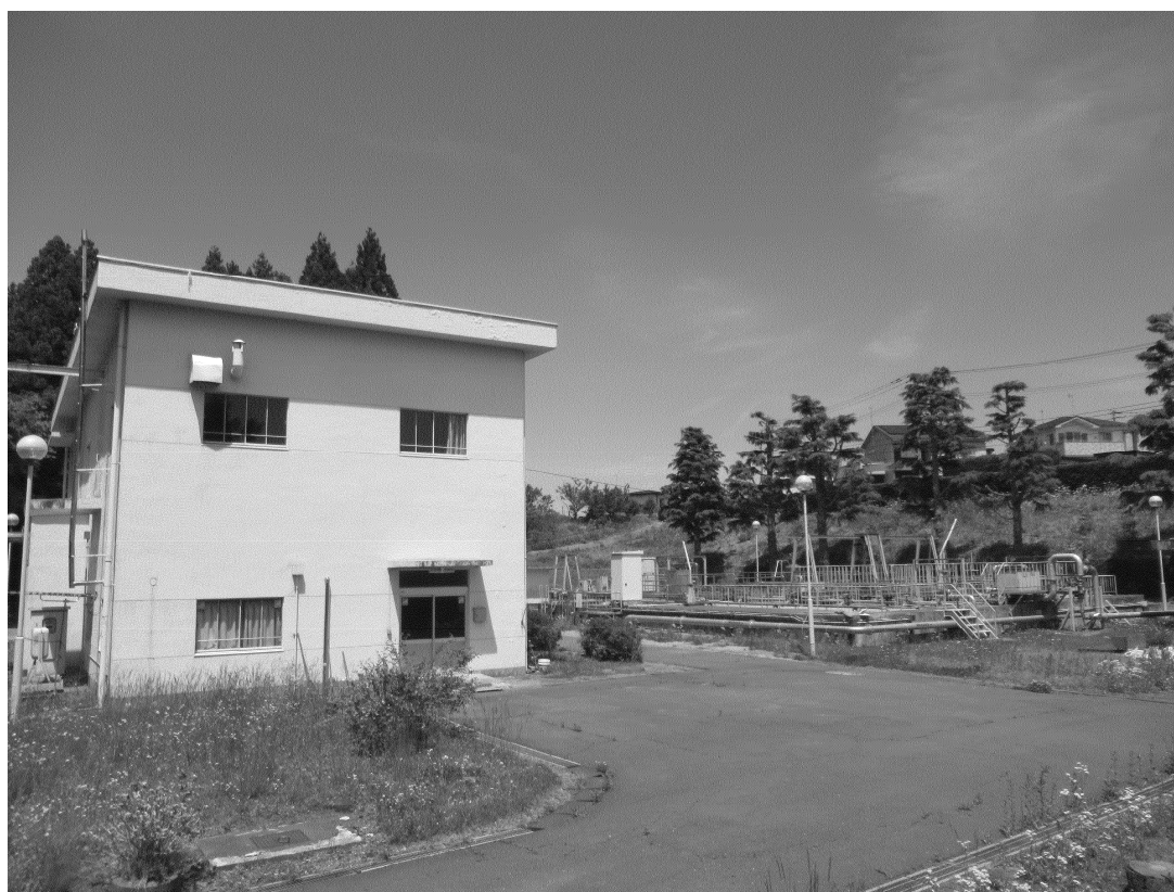
旧是川住宅団地汚水処理場(供用開始 S63.4～廃止 R4.9)
