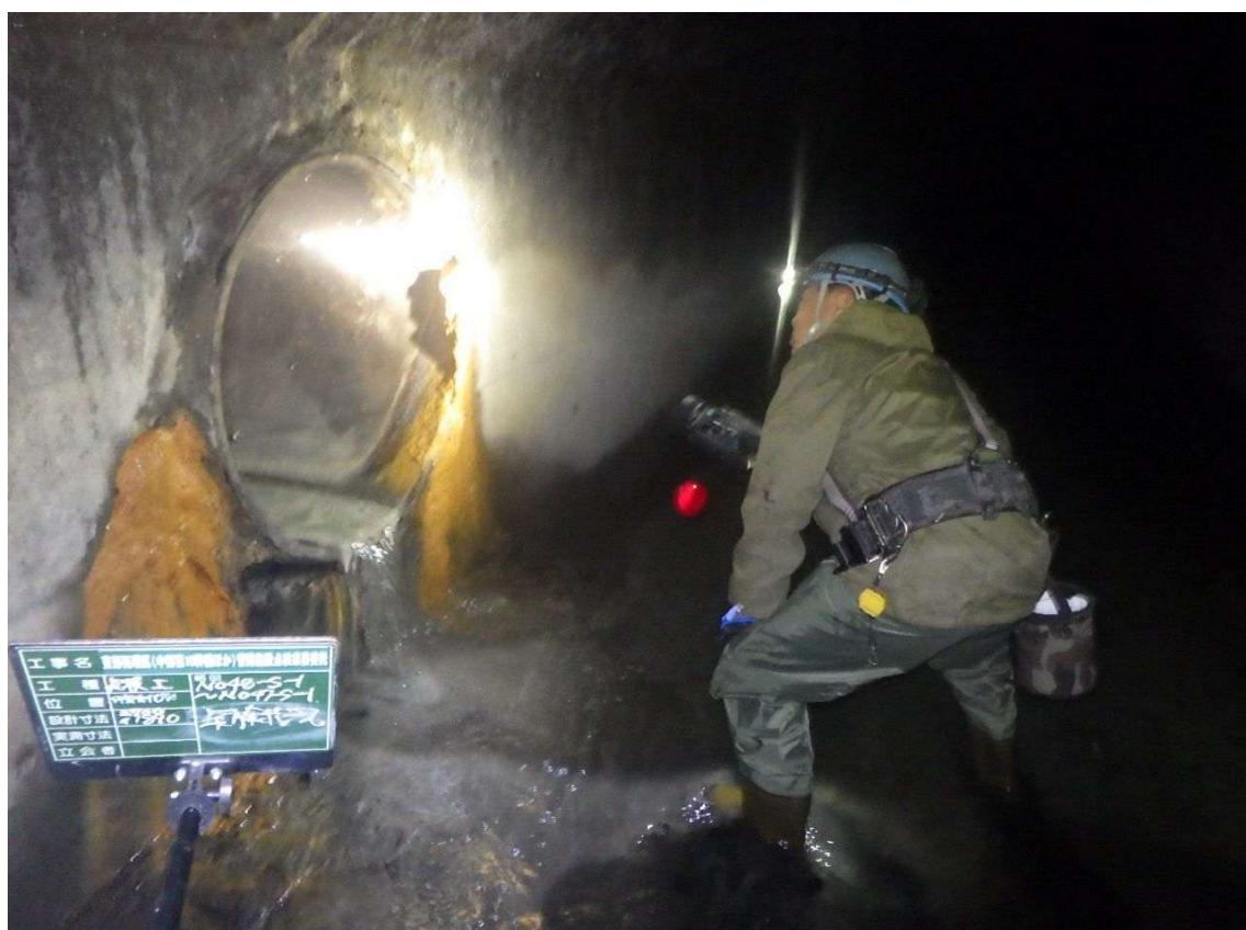
管路施設点検作業の様子
