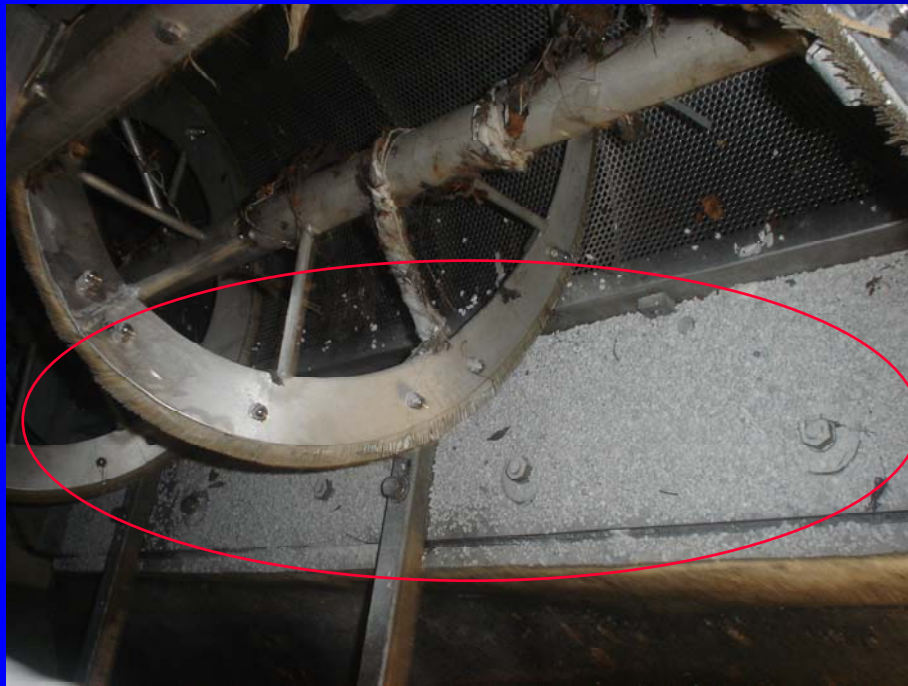
◎H23.4.25越流壁の頂上に白砂を散布
