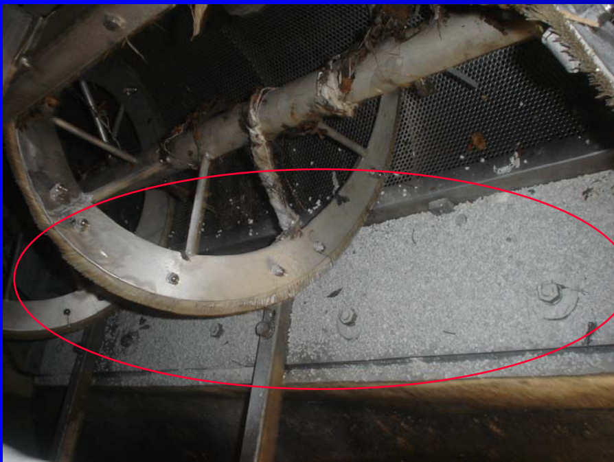
◎H23.6.10越流壁の頂上に白砂を散布
