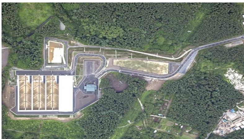
八戸市一般廃棄物最終処分場 H25.7竣工
