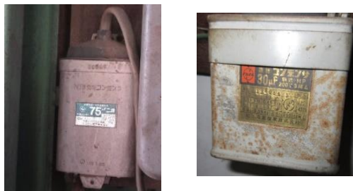
低圧進相コンデンサー (配電盤や壁に設置)
