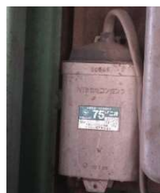
低圧進相コンデンサー (配電盤や壁に設置)
