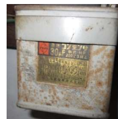
低圧進相コンデンサー (配電盤や壁に設置)
