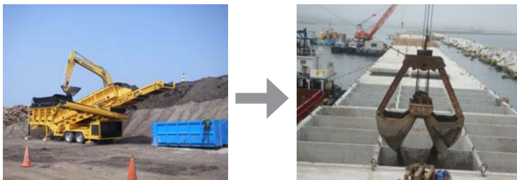
津波堆積物の土砂を防波堤のケーソンの中詰材として再利用
