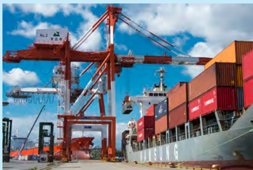
ガントリークレーン荷役状況(八戸港)
