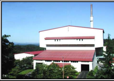
八戸清掃工場第二工場 S55. 3竣工 全連続ストーカ式焼却炉 150t/日×1炉
