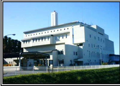
八戸清掃工場第一工場 H8. 7竣工 全連続流動床式焼却炉 150t/日×2炉
