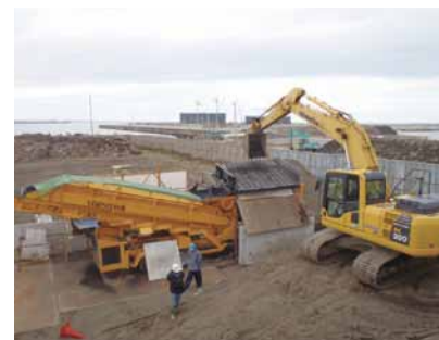
選別作業（中間処理）
