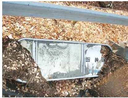
上北沼停留所の破損状況
