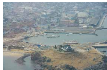
八戸港内の被害状況
