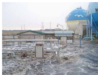
製造設備へ押し寄せる津波
