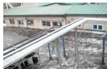
資材倉庫が浸水
