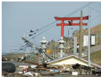
蕪島神社前の電柱倒壊
