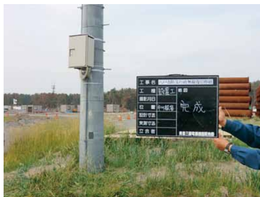
応急復旧（平成23年6月）
