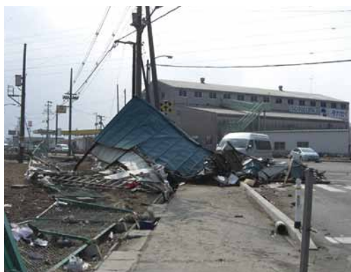
流された屋根が電柱に寄り掛かる（北沼付近）
