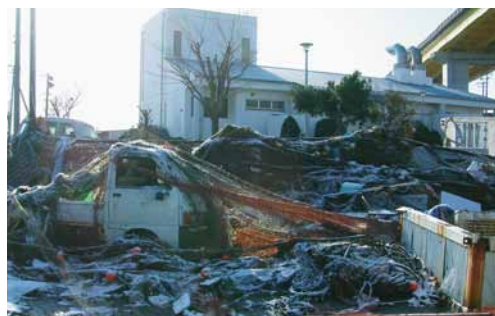
館鼻汚水中継ポンプ場の被害の様子
