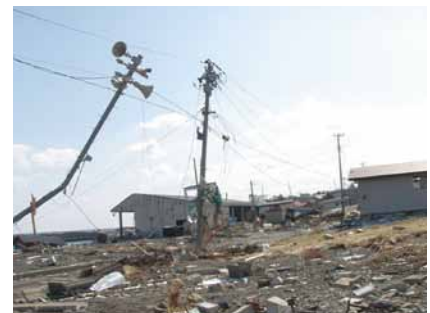
辛うじて建つ電柱と防災無線柱（階上町）
