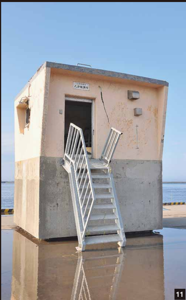
11／津波により建物ごと流出し、 引き揚げられた八戸検潮所 (平成23年6月撮影) 12／岸壁の被害の様子 (平成23年6月撮影)
