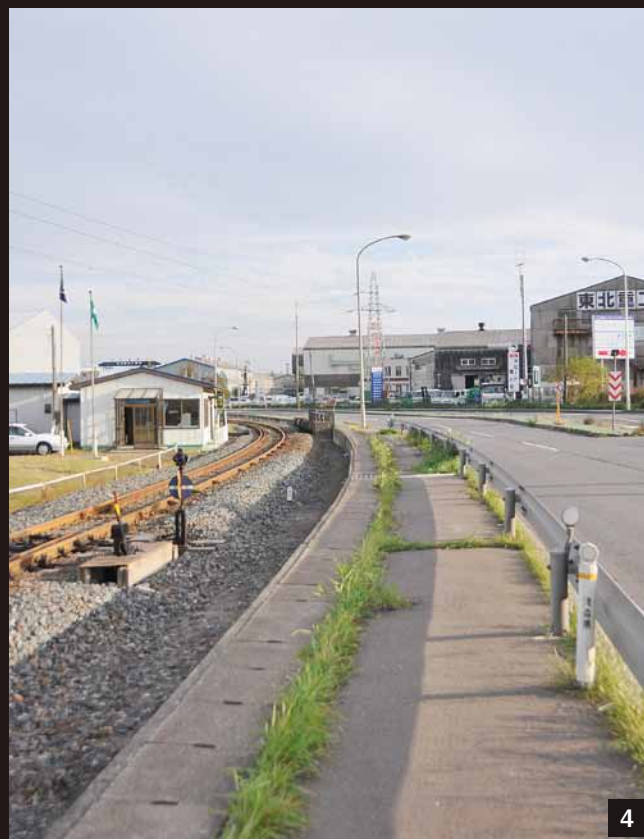
3／配水管空気弁から水が噴出する様子（平成23年3月12日撮影） 4／復旧後の様子（平成23年11月撮影）
