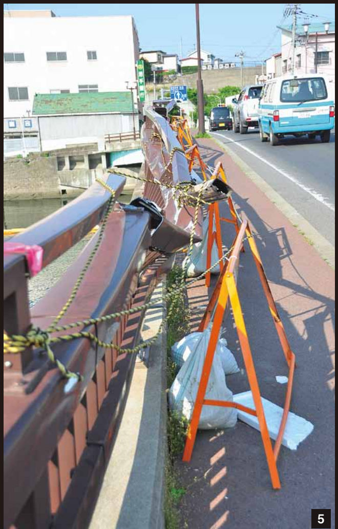
3／新井田川に座礁した漁船の撤去作業の様子 （平成23年6月撮影） 4・5／津波により押し流された船が衝突し、折れ曲がった湊橋の欄干 （平成23年6月撮影）
