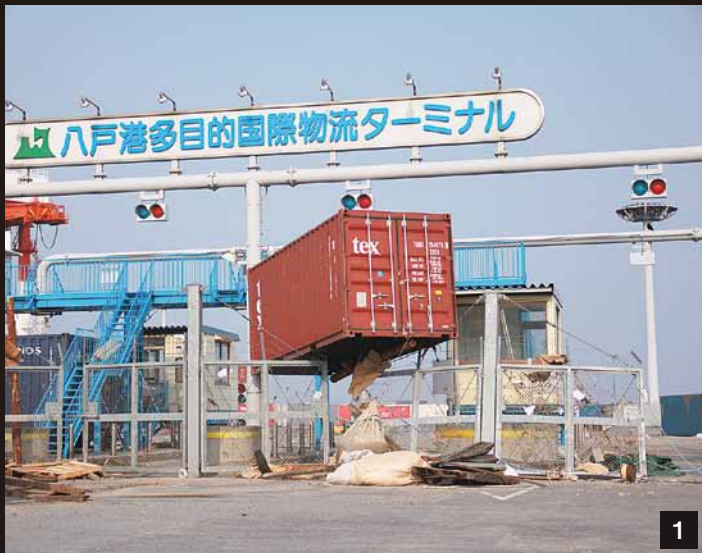
1／八戸港多目的国際物流ターミナルの被害の様子 (平成23年3月14日撮影) 2／復旧後の様子 (平成23年11月撮影)
