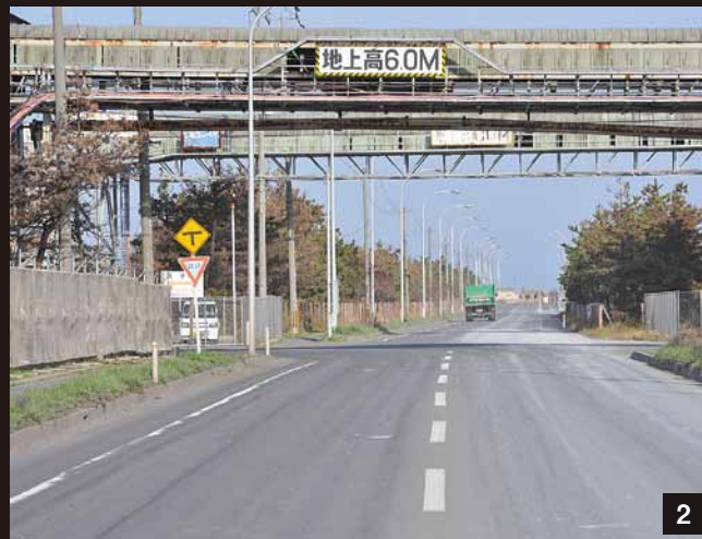
1／三菱製紙八戸工場付近（八太郎4号埠頭線）の被害の様子（平成23年3月12日撮影） 2／復旧後の様子（平成23年11月撮影）
