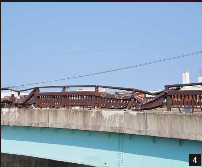
3／新井田川に座礁した漁船の撤去作業の様子 （平成23年6月撮影） 4・5／津波により押し流された船が衝突し、折れ曲がった湊橋の欄干 （平成23年6月撮影）
