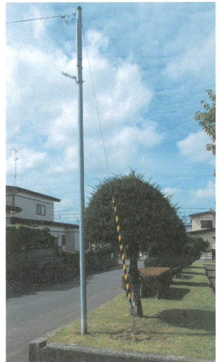
頑丈な状態に補強修繕後
