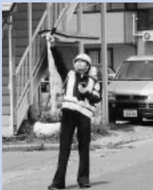
工事中の交通整理
