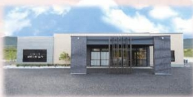
報恩会館 南部 三戸郡南部町大字平字広場22-2
