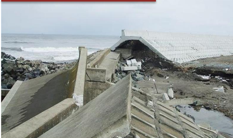
破堤の様子 (五戸川河口部)
