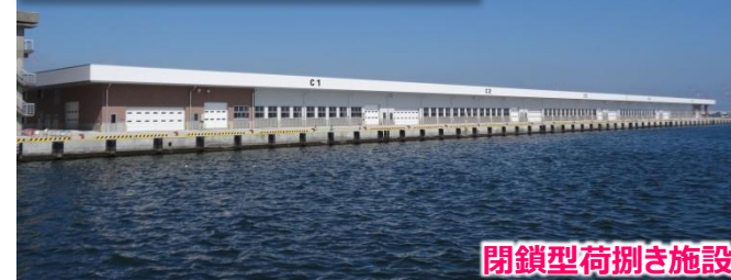
第三魚市場荷さばき所 C 棟
