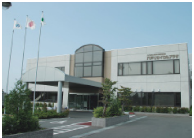
八戸リサイクルセンター
