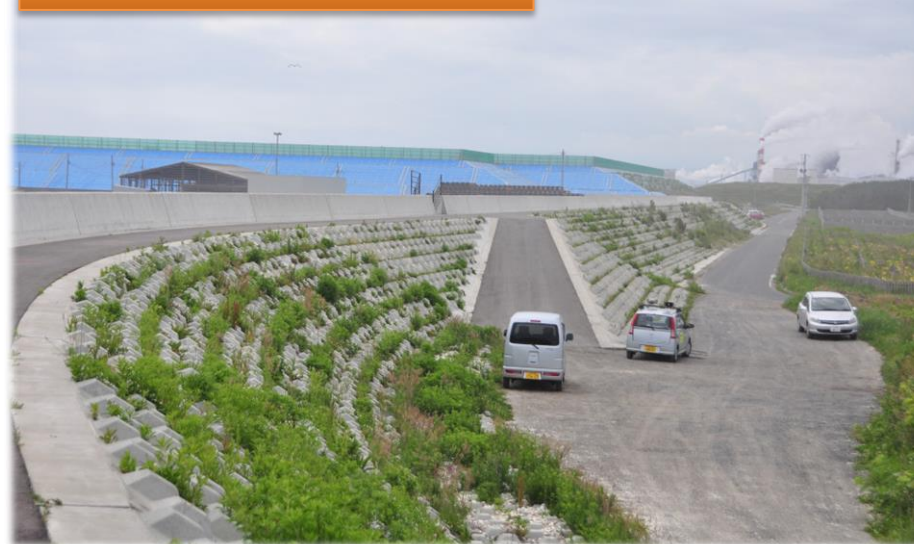
整備後（市川海岸堤防）
