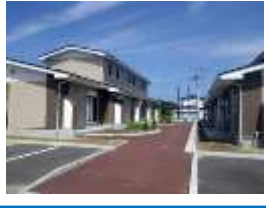
市川工業団地通線道路の改良
