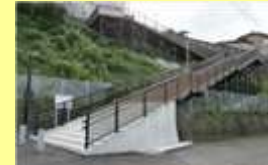
汐越線他避難階段の整備
