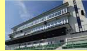
多賀地区津波避難施設 (多賀多目的運動場管理棟4階)
