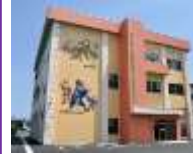
小中野公民館 (防災拠点施設)
