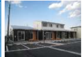
白銀いかずち災害公営住宅
