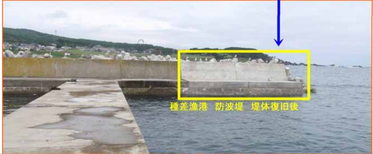
種差漁港 防波堤 堤体 復旧後
