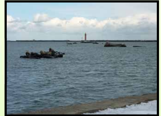
被災直後の状況
