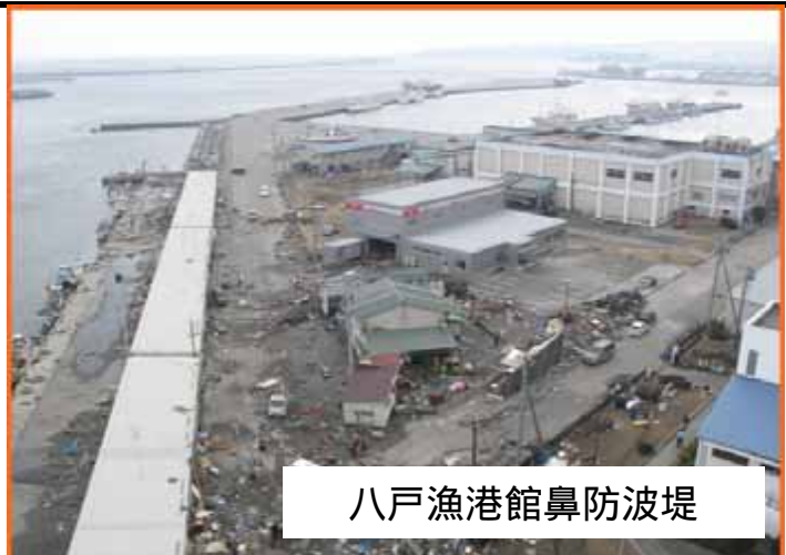
八戸漁港館鼻防波堤 復旧前
