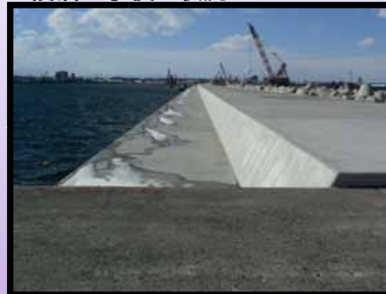
復旧工事後の状況
