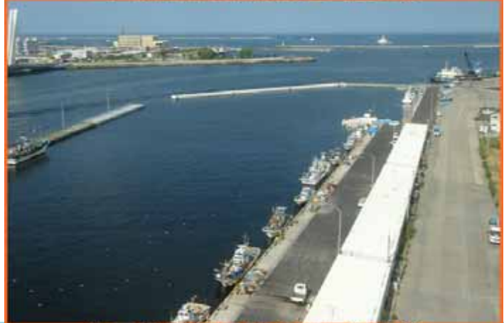
八戸漁港館鼻防波堤 復旧後
