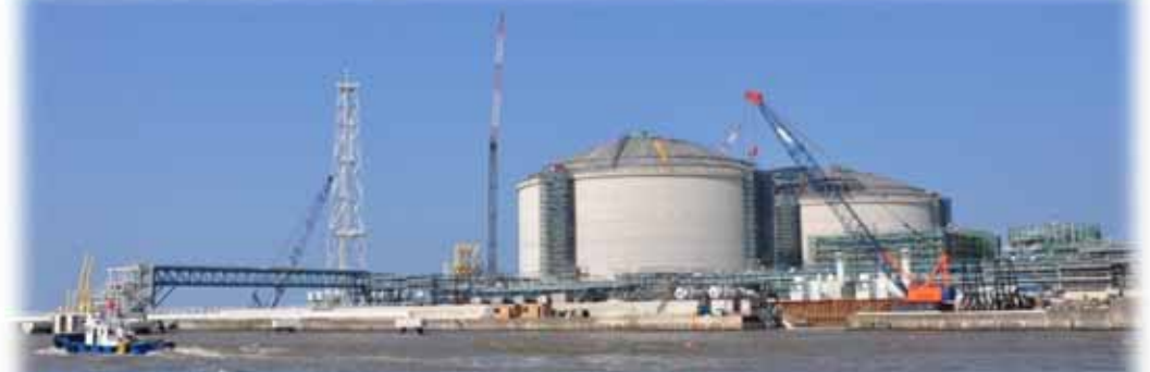
建設工事が進むLNG貯蔵タンク (2011.4.11着工)
