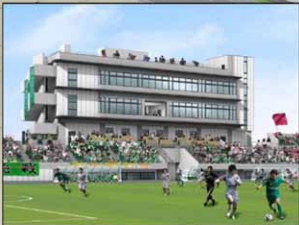
管理棟 (4階部分を津波避難施設として整備)
