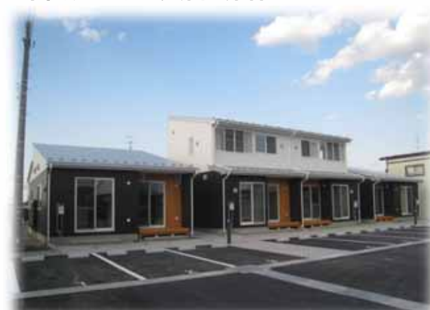
白銀いかずち災害公営住宅
