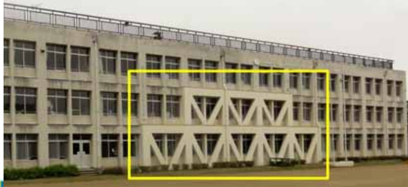
耐震補強された八戸小学校校舎
