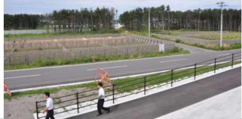
海岸防災林造成事業の状況
