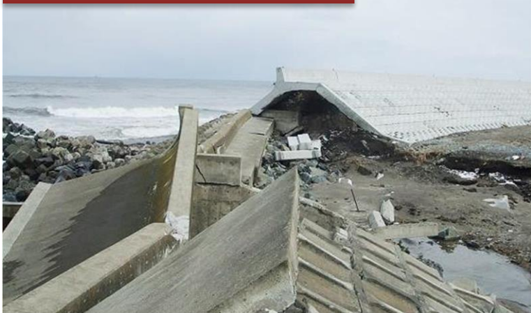
破堤の様子 (五戸川河口部)
