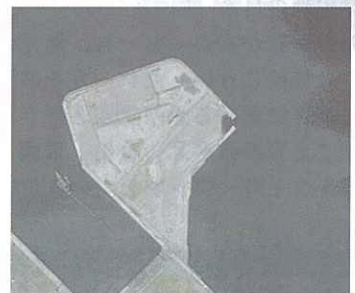
護岸が流出したポートアイランド(右側の欠けた部分)
