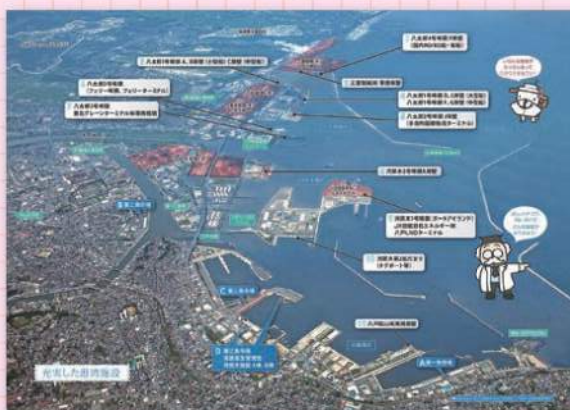
八戸港を一望した港湾施設
