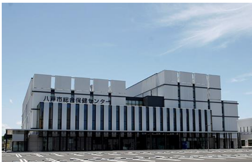
令和2年6月に供用を開始した八戸市総合保健センター
