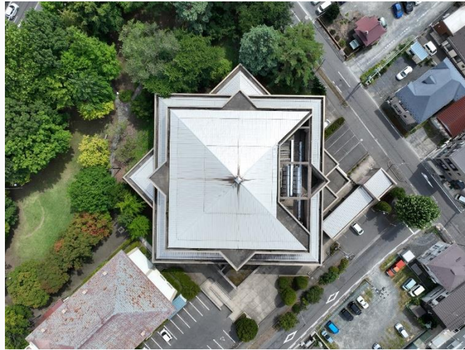
図書館上空からの写真
